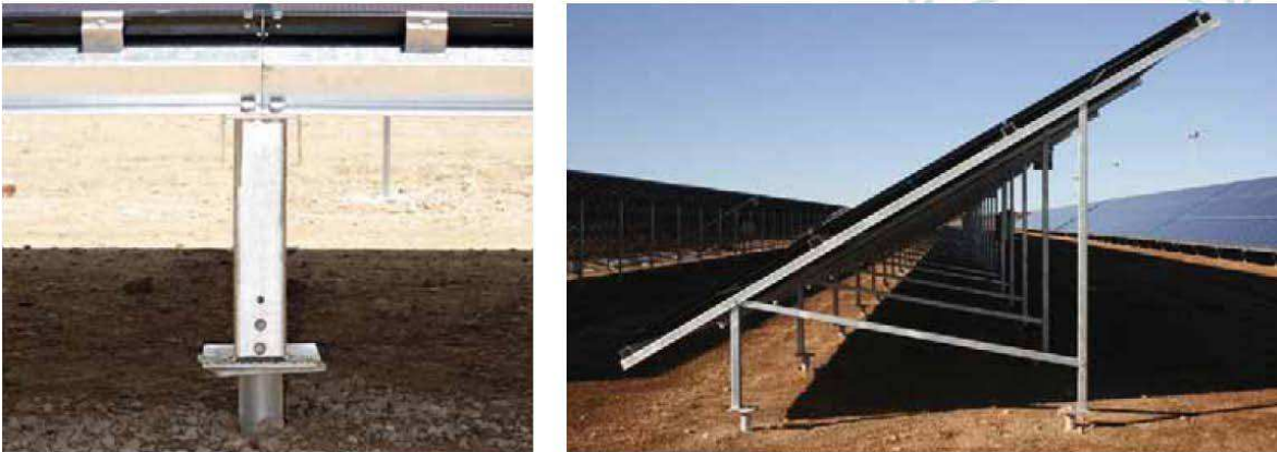
Figura 9. Aplicación típica del método de anclaje de la estructura al suelo.
